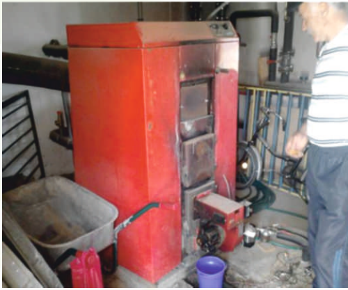
слика бр. 7: Стар котел на нафта
